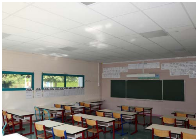
▲ Installation d'éclairage LED dans l'école Jean de La Fontaine
