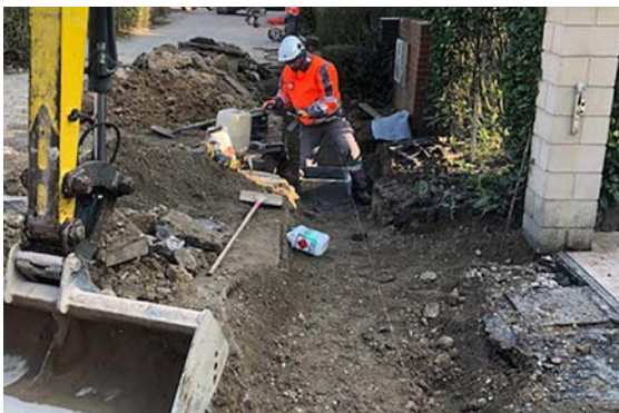
..... ▲ Reprise du caniveau pour améliorer le ruissellement des eaux. .....
