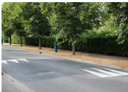
Un nouveau coussin bernlois a été installé boulevard du Champ du Moulin.
