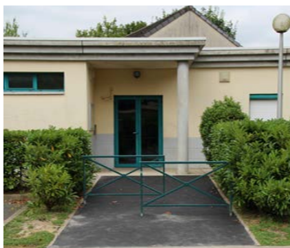
Stade de l'Hermière : une clôture extérieure a été rajoutée et un enrobé a été réalisé pour pouvoir accéder aux vestiaires du terrain et à l'entrée du parking.
