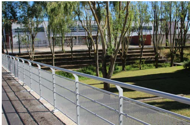
Les barrières du Ru des Gassets ont été remplacées pour sécuriser les abords du Collège comme s'y était engagé le Maire de Serris.
