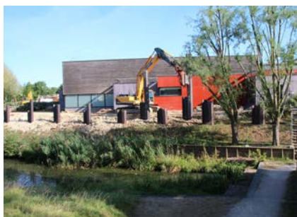
Les travaux de consolidation et de rénovation de la salle polyvalente du gymnase Tabarly continuent pour une ouverture prévue en février 2017.
