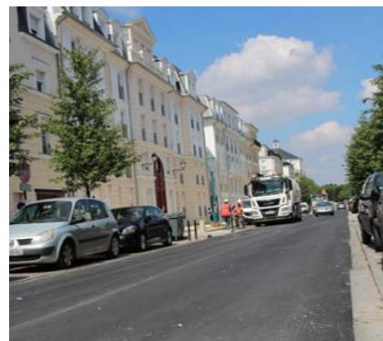
Les travaux d'enrobé et de marquage au sol des Cours de l'Elbe et de la Rue des Scandinaves ont été réalisés fin août.
