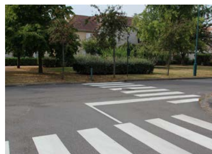
Des travaux de marquage au sol de signalisation (passage piéton, ligne longitudinale) ont été réalisés sur de nombreuses voies.
