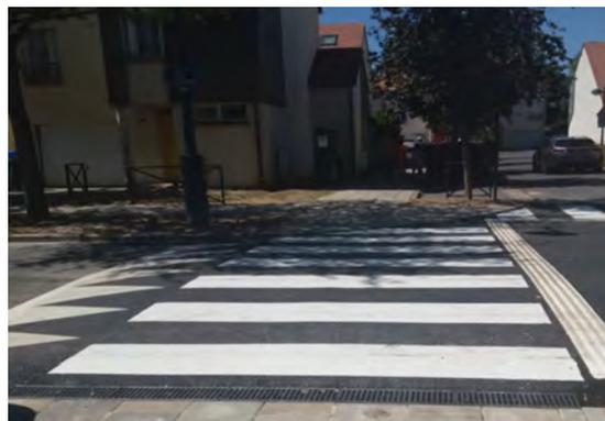
▲ Des travaux de mise en sécurité ont été réalisés à la traversée piétonne située au carrefour rue de l'Hermière / allée du Buisson Cocher, avec la réalisation d'un plateau surélevé en enrobés et la suppression du coussin berlinois et des jardinières situés juste à côté.
