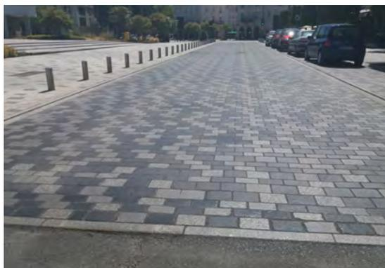
▲ Le cours de l'Elbe présentait des pavés déchaussés, dangereux pour les véhicules, notamment pour les deux roues. Des travaux de réfection de joints ont été réalisés pour remédier à ces problèmes.
